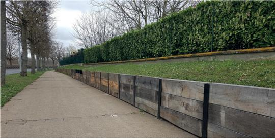
❶ Remplacement du muret de soutènement Avenue André Malraux. Des IPE (poutres métalliques) et des traverses en chêne sont en cours d'installation pour retenir le talus. Coût de l'opération : 10 000 euros
