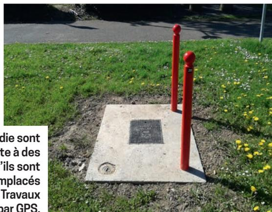
③ Les poteaux d'incendie sont renouvelés (notamment suite à des dégradations ou parce qu'ils sont devenus hors d'usage) et sont remplacés par des bouches d'incendie. Travaux réalisés et financés par GPS.
