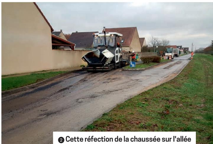
② Cette réfection de la chaussée sur l'allée des Princes a été réalisée de la même manière que dans l'avenue des Tilleuls, les dégâts étaient plus importants encore. Il a fallu procéder à des purges pour renforcer la structure de la chaussée. Coût des travaux réalisés par l'entreprise Jean Lefebvre : 69 000 euros.
