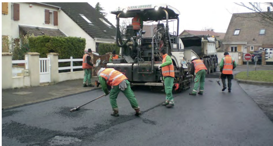
Réfection de voirie sur l'allée des Vanneaux et l'allée des Verdiers
