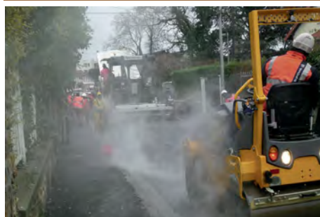
Réfection de la voirie et des trottoirs rue Louise Michel
