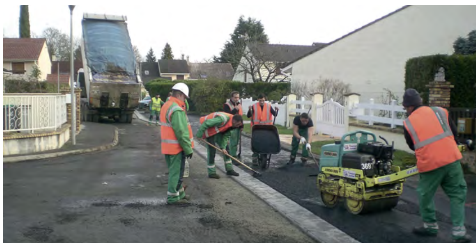
Réfection de la voirie allée des Roitelets avec reprise des caniveaux
