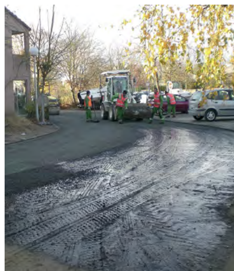
Réfection de voirie rue Danielle Casanova
