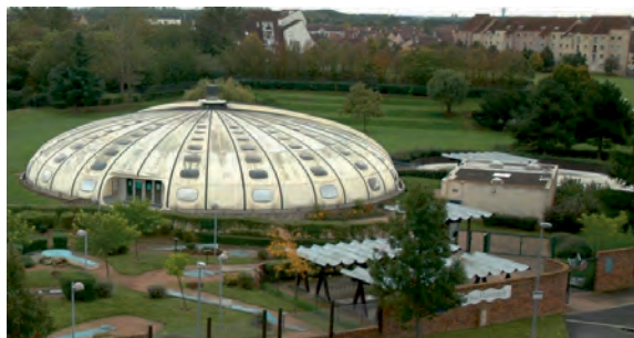
La piscine fermera ses portes pour travaux le 22 décembre 2017 pour une période de 18 mois.
