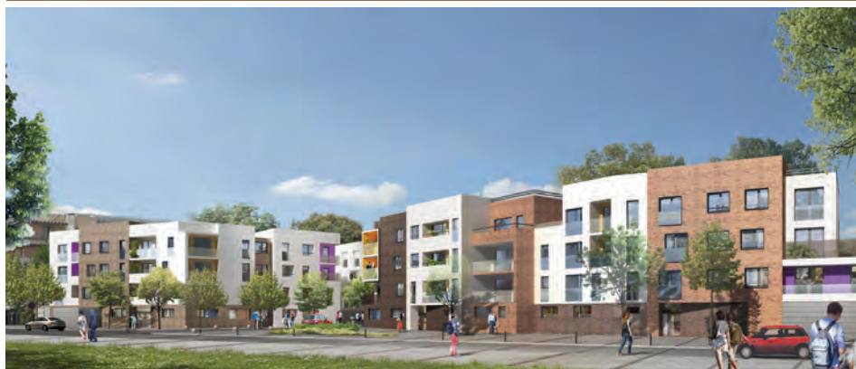
Vue depuis la rue des Brandons (image non contractuelle) à l'horizon de la fin 2018
