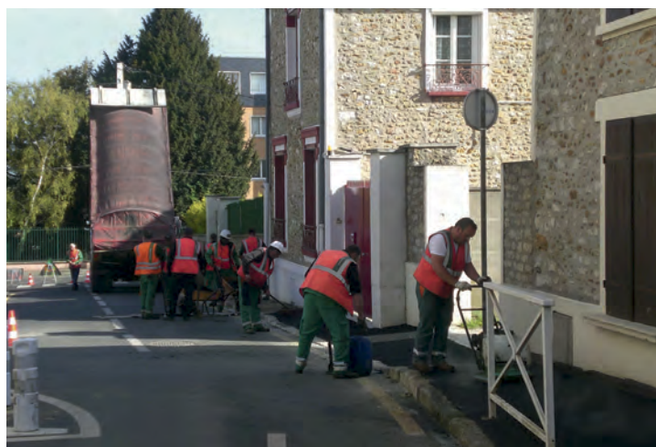
Réfection trottoirs rue St Jacques
