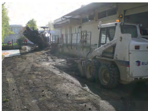
Réfection de la cour de la restauration Paloiseil
