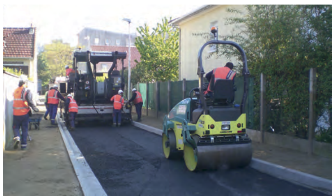
Création d'une voie de circulation afin d'ouvrir l'allée des Cormiers avec un changement de sens de circulation depuis la rue Louise Michel.
