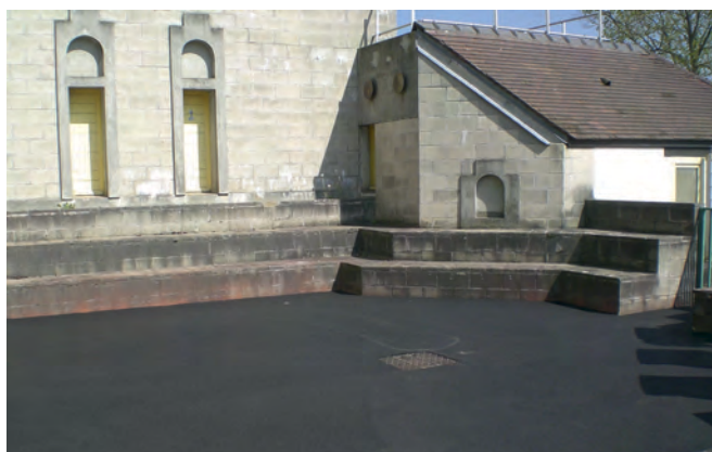
Réfection de l'arène groupe scolaire La Noue
