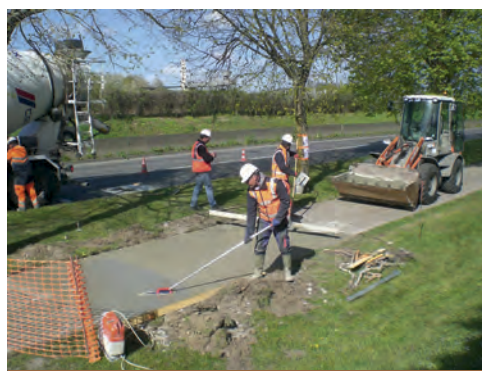
Réfection piste cyclable A Malraux
