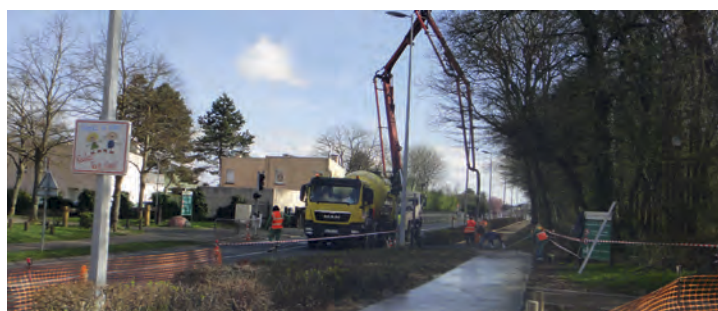
En face du collège les Cités Unies, le long du bois, réfection de la piste en béton désactivé en remplacement des dalles qui se soulevaient et de ce fait posaient un problème de sécurité (les travaux se feront en plusieurs phases).
