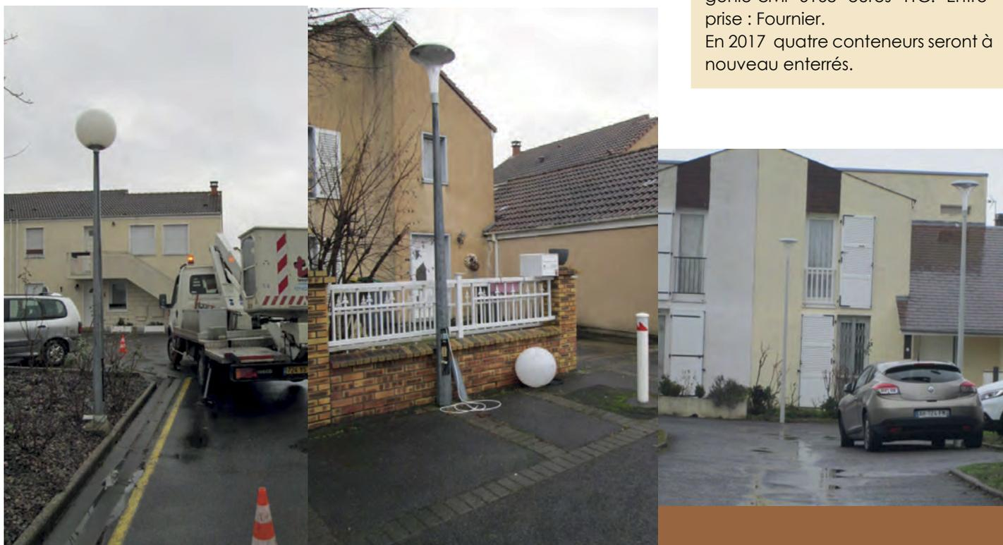
Avant / Après : les boules sont remplacées par des lanternes en LED nouvelle génération moins énergivores
