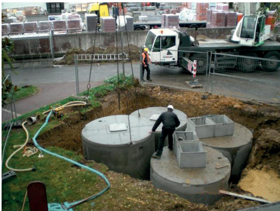
**Une grue de 40 tonnes a été nécessaire pour permettre le levage et la mise en place des quatre cuves.**
