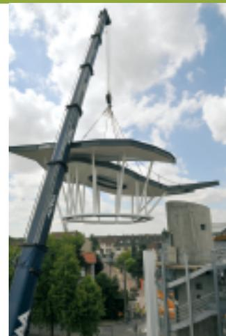
Le jeudi 12 mai 2011, un oiseau métallique de 22 tonnes a été levé et déposé sur le toit du pylone qui abrite l'ascenseur et l'escalier de secours du parking de la gare.
