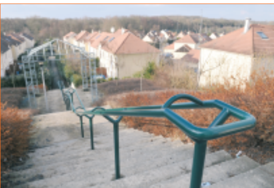
Les personnes à mobilité réduite (comme les personnes âgées) sont également concernées. Par exemple, une rampe a été installée entre la rue de la Cristallerie et la rue de Varennes.
