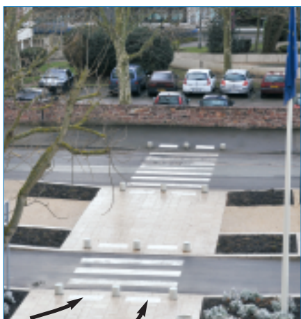
Bandes podotactiles pour signaler les passages piétons
