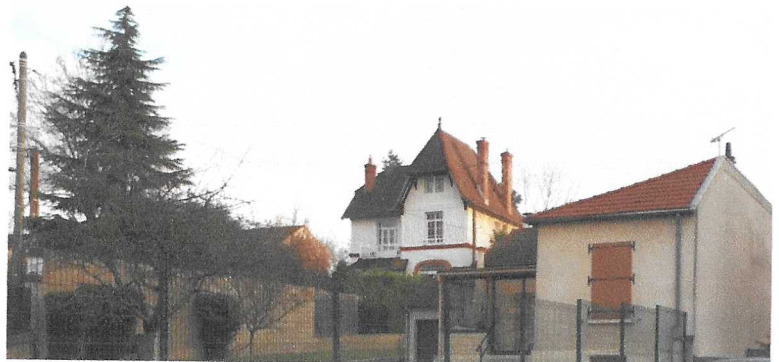
31 rue des Marnières
