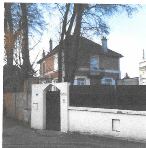
12 rue Eugène Delaplanche
