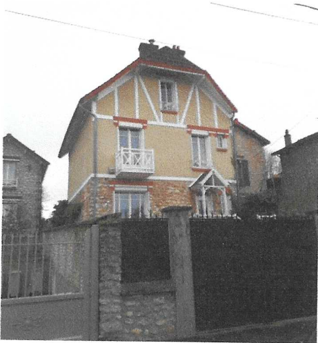
5 rue des Marnières
