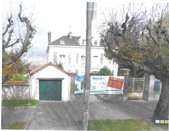
Maison démolie 2 avenue de la République
