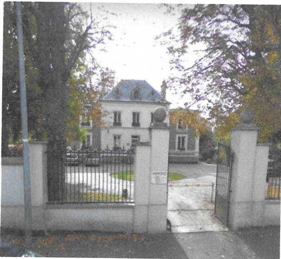
Maison démolie 11 avenue de la République
