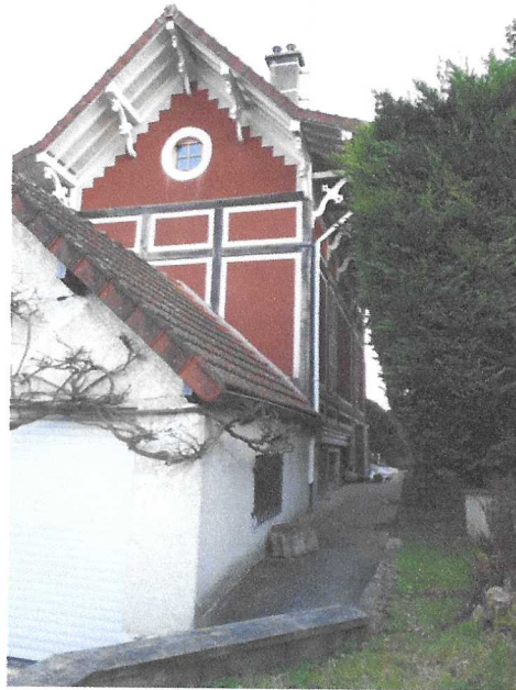
60 allée de l'Yerres
