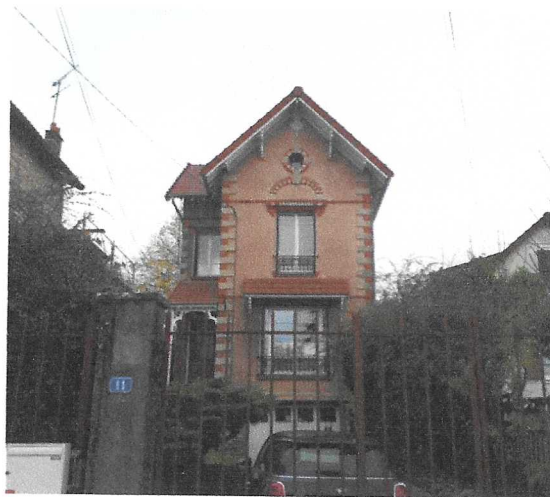
11 rue des Marnières
