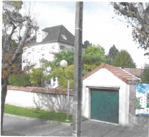
Maison démolie 4 avenue de la République
