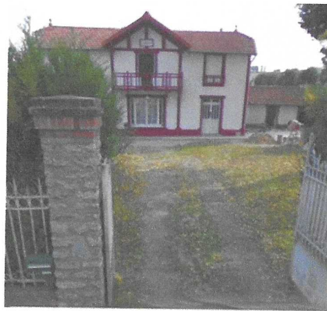
6 rue des Vallées (29 logements en construction)
