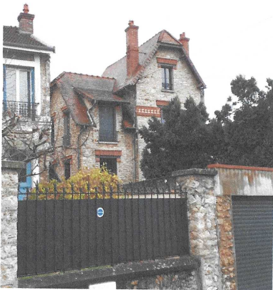
23 rue des Marnières
